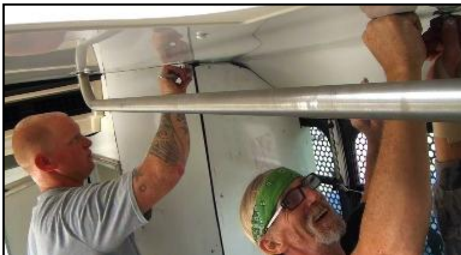
El primo de Timothy, Chris Greenberg, & su padre, Mike Iller, haciendo a prueba de agua los pernos que aseguran el portaequipaje de carga.
